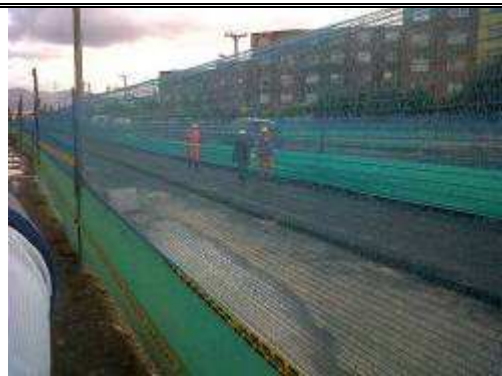
Imagen No.2 Cerramiento del frente de obra
