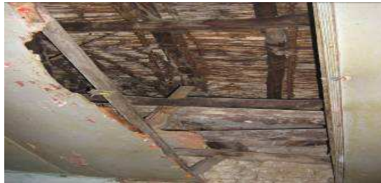
Vista del Cielo raso
