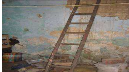
Vista de uno de sus muros
