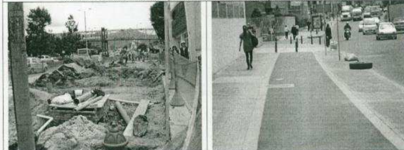
A 8 de marzo de 2011 faltando quince (15) días para terminar el contrato aun falta por ejecutar un 7.34% por ejecutar con un atraso del 6.03%
