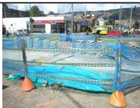
Imagen No.2 Cerramiento del área de trabajo
