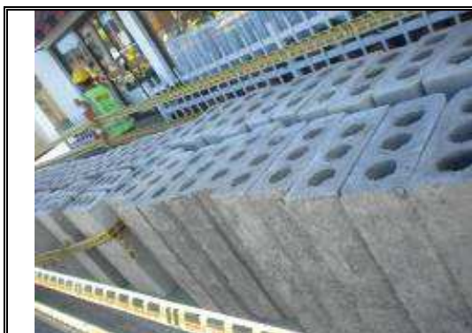
Imagen No.1 Acopio de materiales, con señalización
