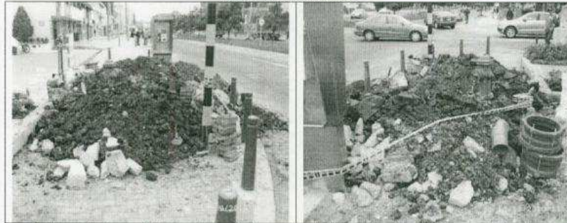
Trabajos realizados por la Empresa de Acueducto y Alcantarillado en andenes recientemente intervenidos, calle 109 costado oriental.
