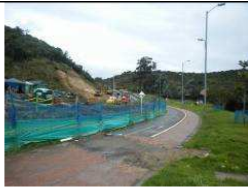
Imagen No.4 Cerramiento del área de intervención
