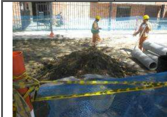
Imagen No.1 Escombros recolectados durante el proceso de construcción
