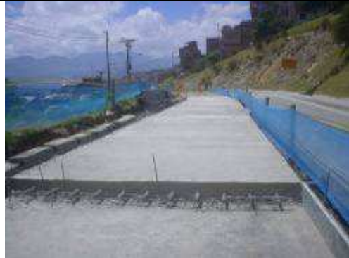
Rehabilitación en concreto
