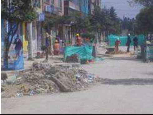
Asfalto objetado por la Interventoría por el no cumplimiento de densidades
