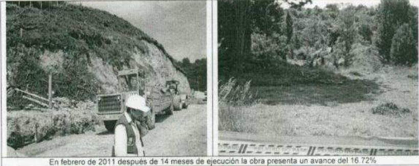
En febrero de 2011 después de 14 meses de ejecución la obra presenta un avance del 16.72%
