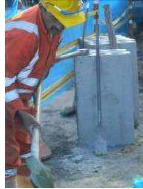
Imagen No.4 Se observa trabajadores sin elementos de protección personal
