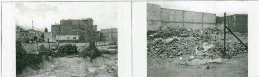
A marzo de 2011 las obras continúan suspendidas por falta de interventoría y el estado es de total abandono.
