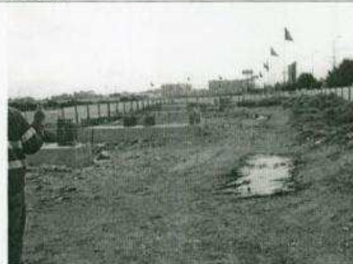
Proyecto 317. En febrero 24 de 2011 la obra presenta un atraso del 35.23%
