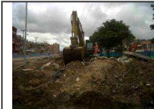
Imagen No.1 Generación de escombros en el frente de Obra
