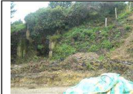
Imagen No.3 Acumulación de material vegetal
