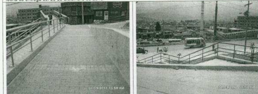
Dos (2) meses de terminado el plazo contractual a marzo 1 de 2011 aun falta dar terminado el Puente Peatonal de Meissen y aseo al espacio público
