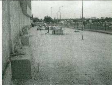
Proyecto 318: En febrero 24 de 2011 la obra presenta un atraso del 22.29%
