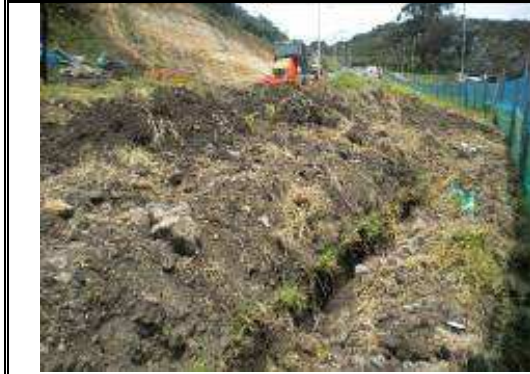
Imagen No.5 Acumulación de escombros durante la construcción
