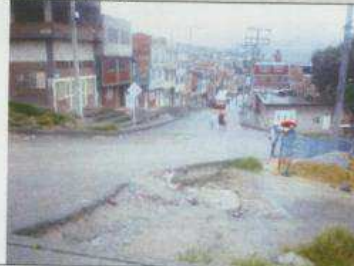
Tramo sin iniciar
