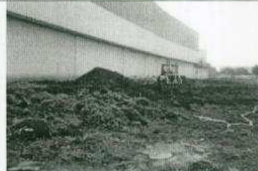
Proyecto 318: Una reiniciadas las obras después de 7 meses de suspensión, en diciembre se cumplía con la nueva programación
